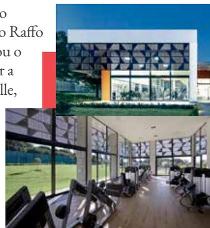
cuidado especial, com foco no eixo visual, mas foi preciso tomar cuidado com a insolação. “Os elementos vazados e triangulares que usamos no projeto fazem parte da construção plástica do edifício, mas também são peças de alumínio composto que servem para proteção solar, permitem a iluminação, ventilação e visibilidade. Usamos ainda uma cobertura para academia, toda preparada para captação de água da chuva”.
